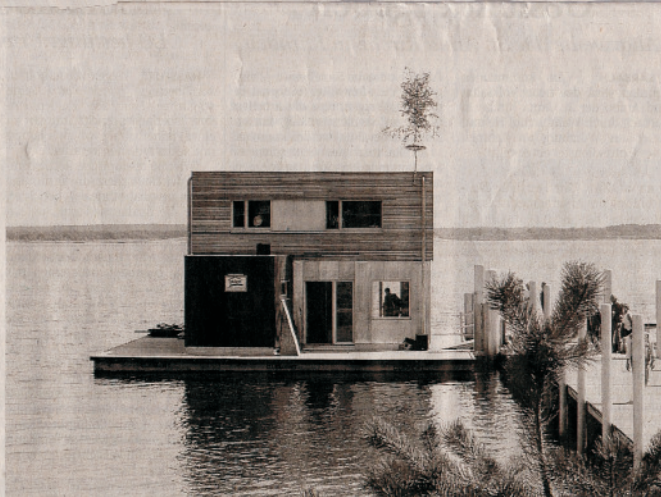
Auf einem 180 Quadratmeter großen und 100 Tonnen schweren schwimmenden Ponton steht das zweistöckige Haus mit einer Nutzfläche von 125 Quadratmetern.
